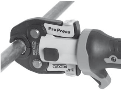
Abbildung 7 – Anbringen von Scherenbacken am Fitting
