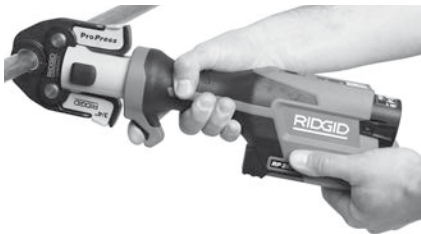
Afbeelding 9 - De fitting persen
