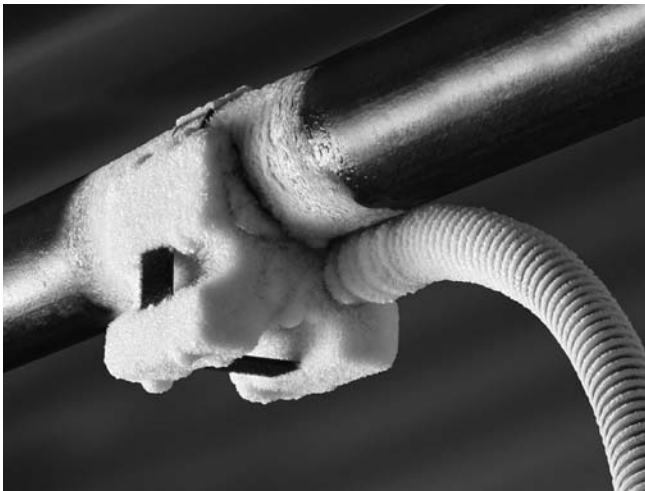
Figura 9 – Cabezal congelado contra la cañería
